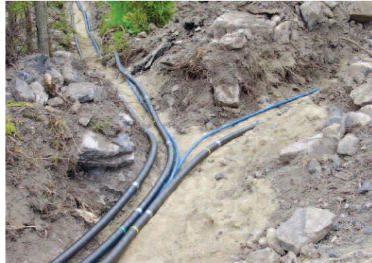
Installation du système CARAPACE
